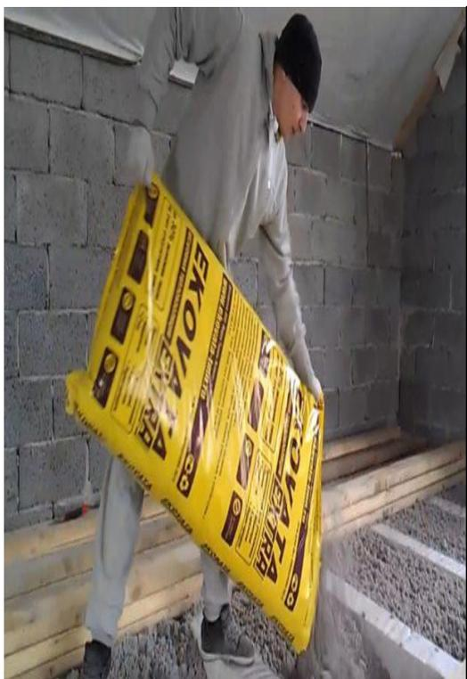
Ручная засыпка, открытые горизонтальные конструкции, полы, перекрытия
