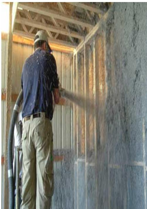
Монтаж влажно-клеевым способом на горизонтальные, наклонные и вертикальные конструкции, плотность 75 кг/м3. – Полы, стены, кровли :
