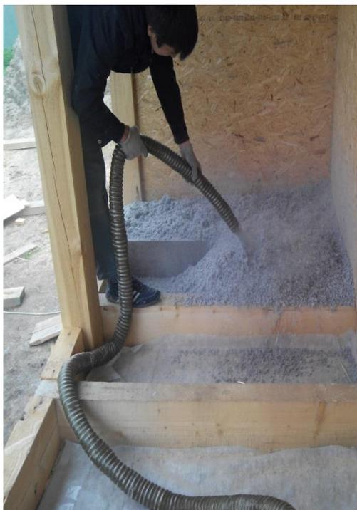
Утепление **открытых** горизонтальных конструкций, плотность **35 кг/м<sup>3</sup>**. – Полы, перекрытия :
