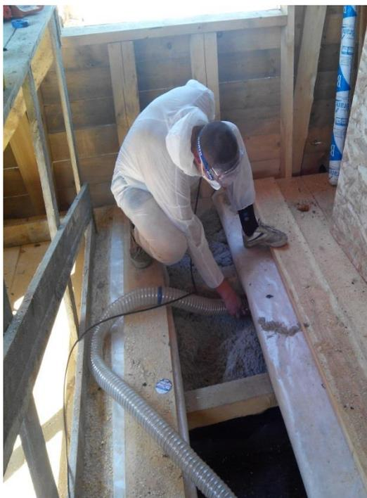
Утепление **закрытых** горизонтальных конструкций, плотность **45 кг/м<sup>3</sup>**. – Полы, перекрытия:
